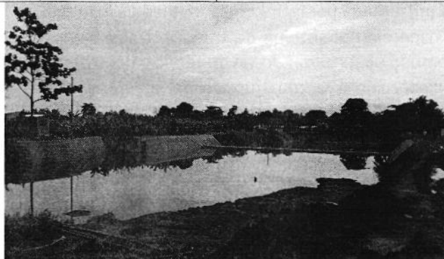
Fotografía 3. Construcción de la represa sobre el río Chilintomo
