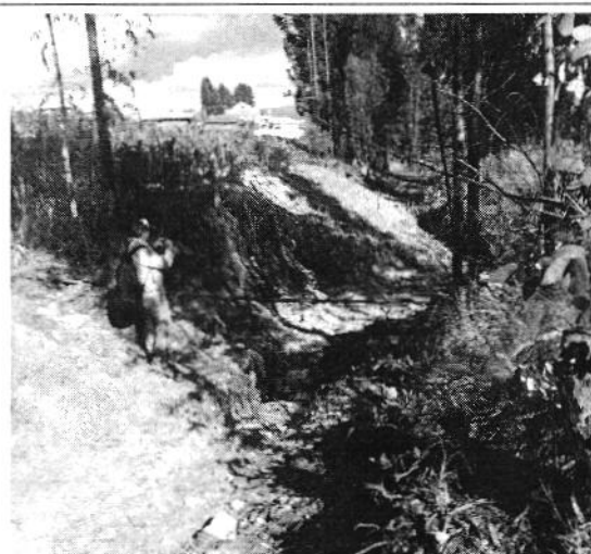
Inspección en Quebrada
