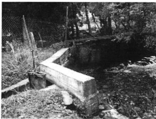
Fotografía 1. Obra de captación en el Río Quinoas, predio de la Sra. María Guerrero.
