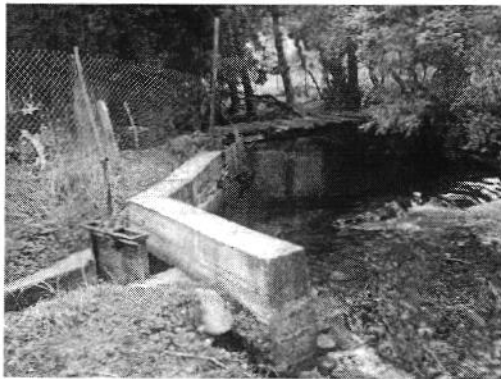
Fotografía 1. Obra de captación en el Río Quinoas, predio de la Sra. María Guerrero.
