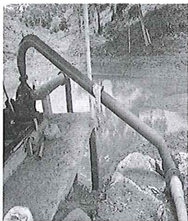
Fotografía 5. Sitio de Captación y Bombeo.
