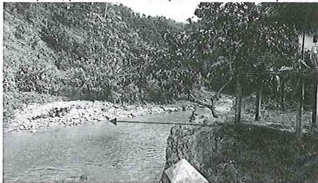
Fotografía 2. Paso dañado hacia predio de la Señora Narcisa Ramón.
