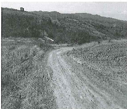
Fotografía 4. Presa El Azúcar – ingreso
