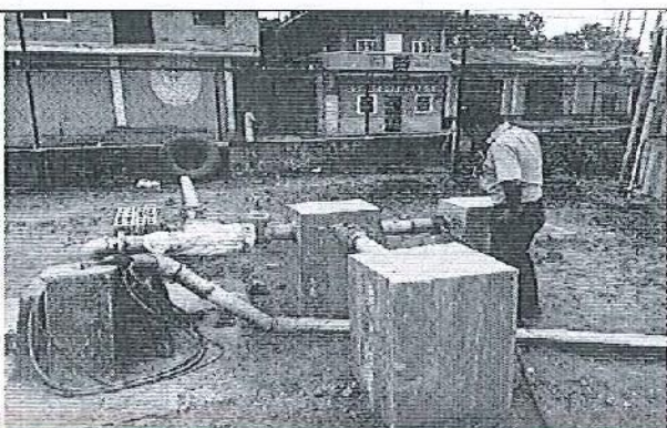
Ilustración 3. Inspección de las fuentes de agua cruda (pozos) del GADM de Urdaneta.
