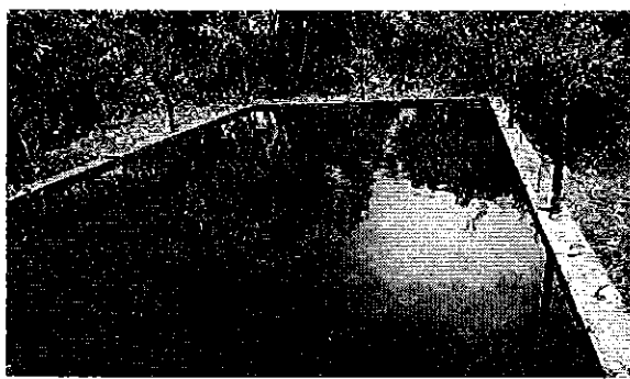
Fotografía 4.- Reservorio de agua
