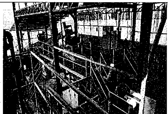
Fotografía 3.- Planta de procesamiento del mineral
