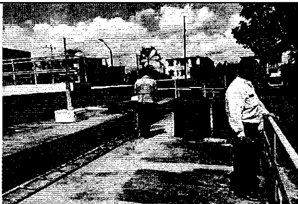
Ilustración 3. Verificación del funcionamiento de la infraestructura con el ciudadano y funcionarios del GADM de Quevedo.
