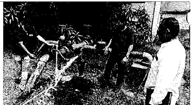
Ilustración 2. Verificación del funcionamiento de la infraestructura con el ciudadano y funcionarios del GADM de Quevedo.
