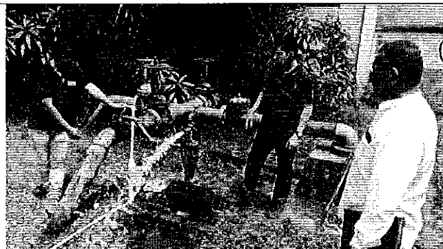
Ilustración 2. Verificación del funcionamiento de la infraestructura con el ciudadano y funcionarios del GADM de Quevedo.
