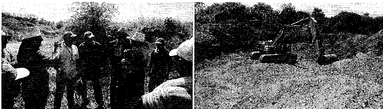
Fotografía 3. Visita técnica y recorrido por el estero Comején.
