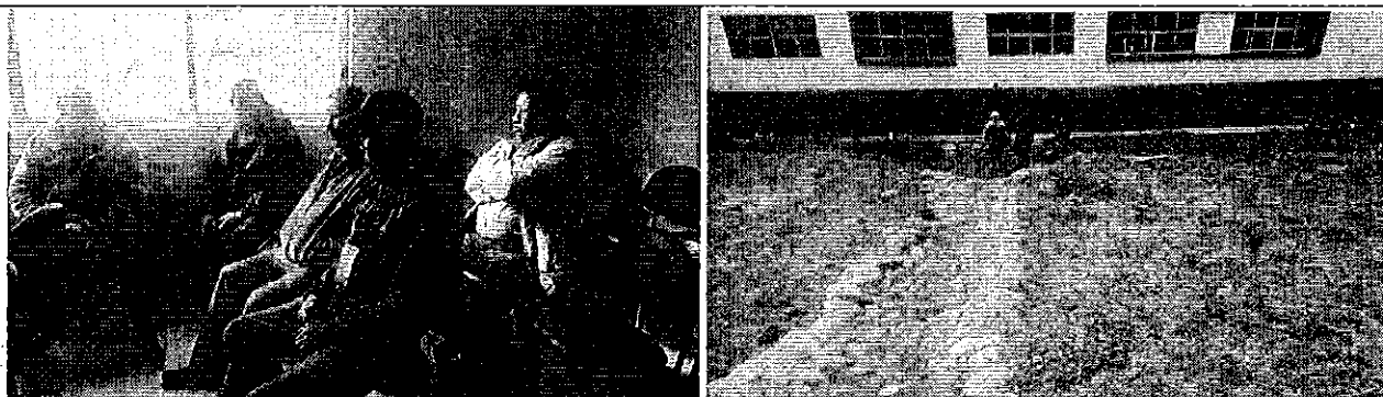
Fotografía 2. Inspección técnica para constatar los hechos denunciados.
