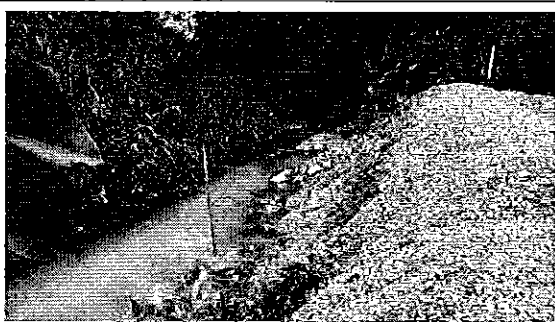
Fotografía 1.- Acumulación de material Pétreo en el margen de protección hídrica.
