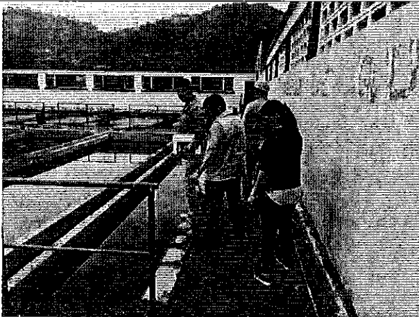
Ilustración 3. Visita técnica a las instalaciones al sistema de agua potable del GADM de Santa Ana.
