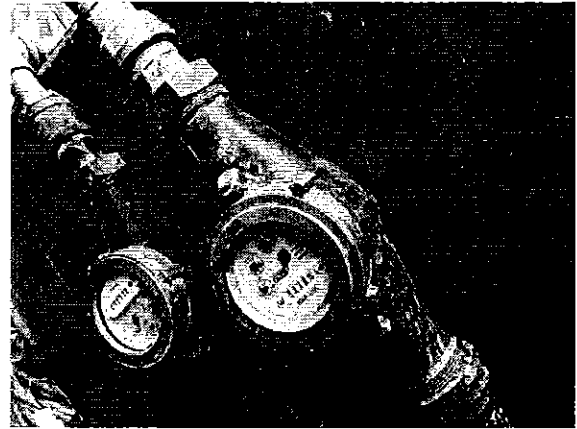
Fotografía 4.- Aparatos de medición de flujo.
