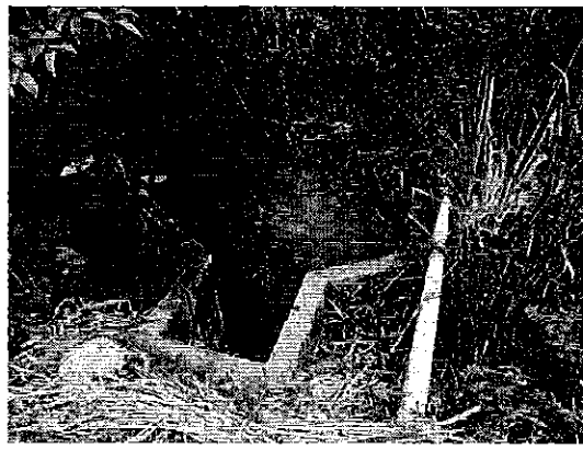
Fotografía 3. Canales de recirculación de agua.
