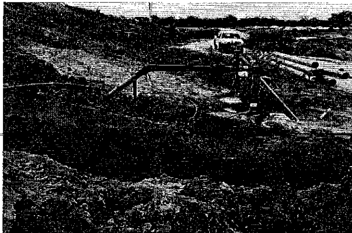
Fotografía 3. Inspección técnica a camaroneras de la zona rural de Arenillas.
