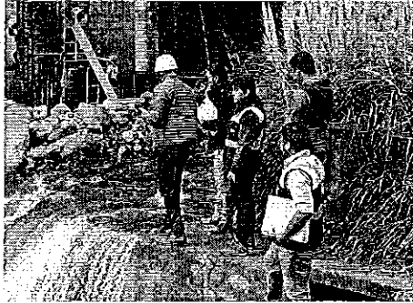
Fotografía 1. Inspección en compañía de los representantes y/o delegados del Gad Municipal de Ambato y la empresa constructora en las riberas del río Ambato.
