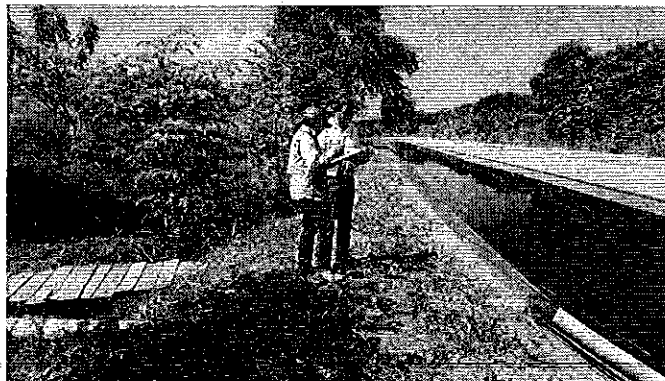
Fotografía 4. Inspección técnica y recorrido in situ.
