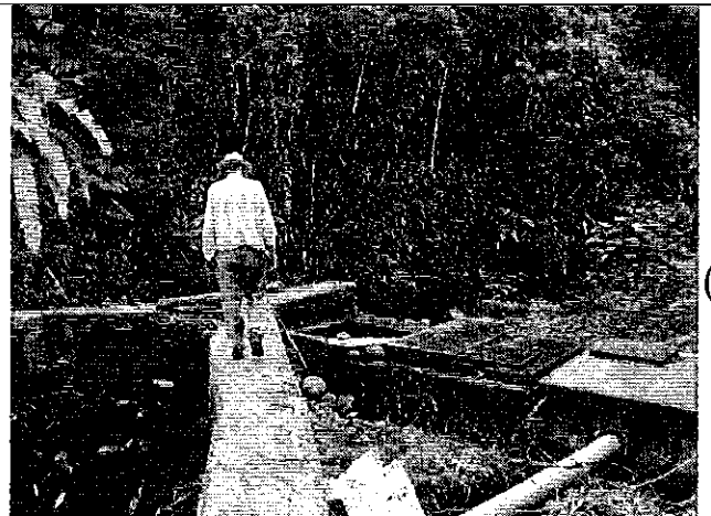
Ilustración 2. Captación del sistema de agua potable de Valle Hermoso
