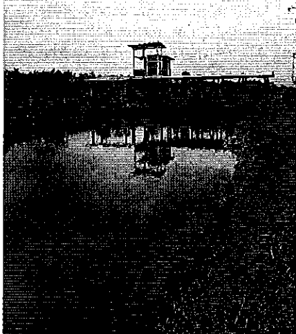
Fotografía 3.- Estación de bombeo
