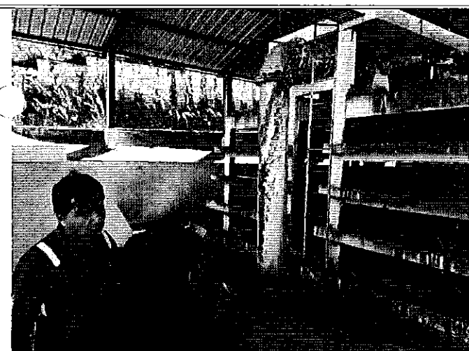
Ilustración 3. Planta de Agua Potable del GADM de Ibarra
