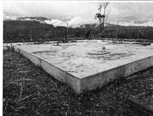
Fotografía 8. Inspección del estado de los tanques de almacenamiento (rectangular).
