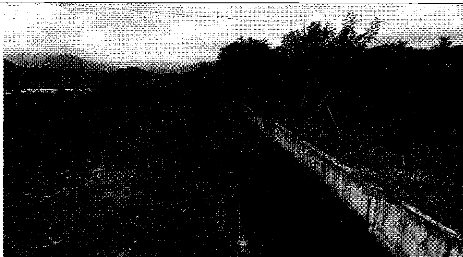
Canal de riego principal rehabilitado, sistema de riego público Santa Rosa
