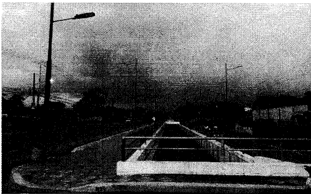
Canal de riego principal, sistema de riego Pasaje-Machala
