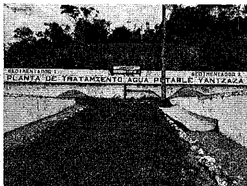
Fotografía 4. Infraestructura de planta de tratamiento.
