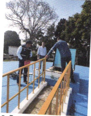
Fotografía 7. Tanque de almacenamiento de agua potable.
