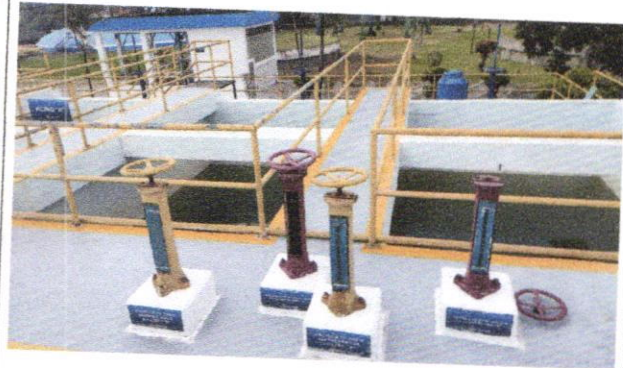
Fotografía 4. Inspección de la planta de tratamiento de agua para consumo humano.
