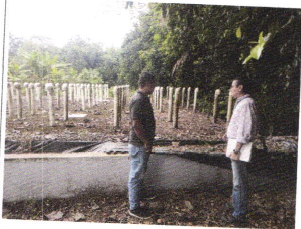
Fotografía 11. Recorrido por el sistema planta de tratamiento de aguas residuales.
