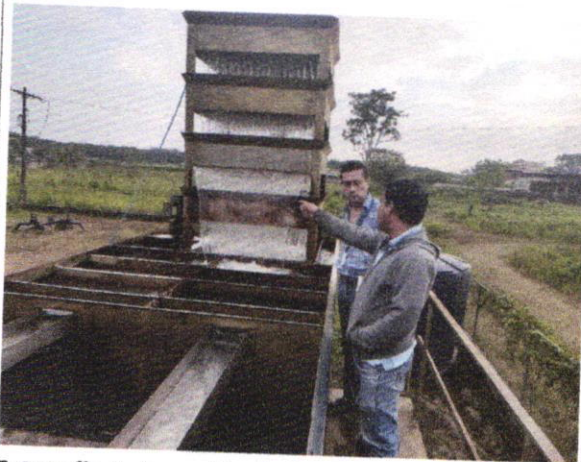
Fotografía 5. Inspección de la planta de tratamiento de agua para consumo humano.
