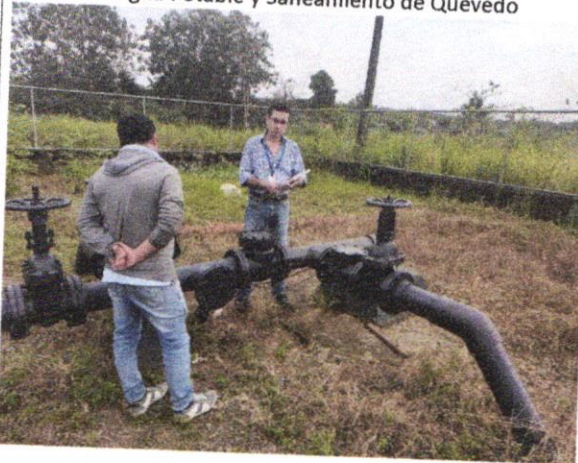
Fotografía 3. Obra de captación de agua en pozo somero.
