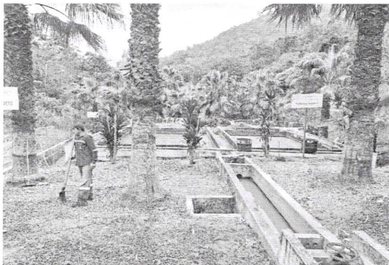
Planta de tratamiento de aguas residuales de la ciudad de Olmedo
