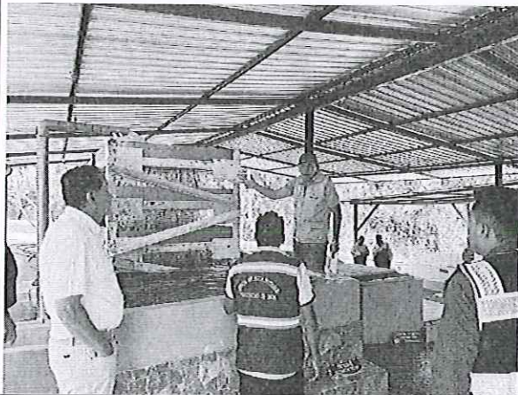
Fotografía 1. Inspección a la planta de tratamiento de agua potable de la junta "Voluntad de Dios"
