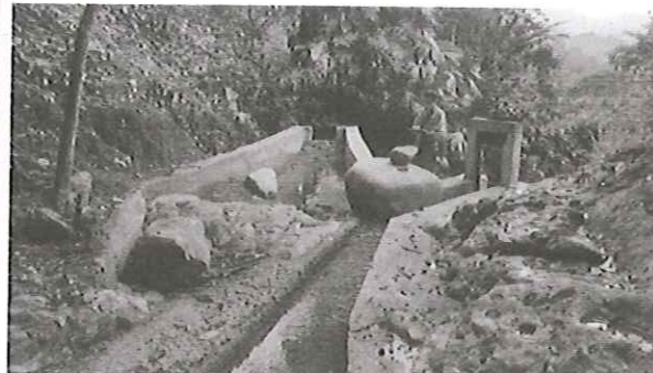
Fotografía 2. Obra de captación superficial de agua para consumo humano
