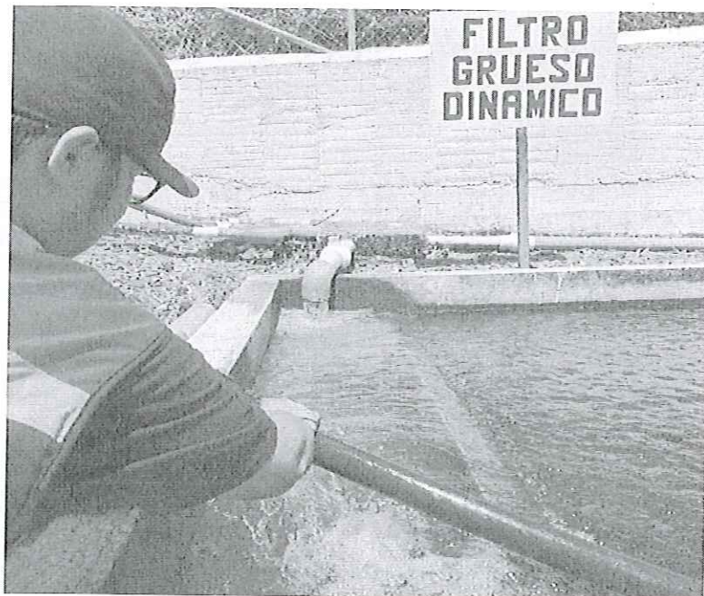
Inspección a la planta de tratamiento de agua de la ciudad de Amaluza (cantón Espíndola)
