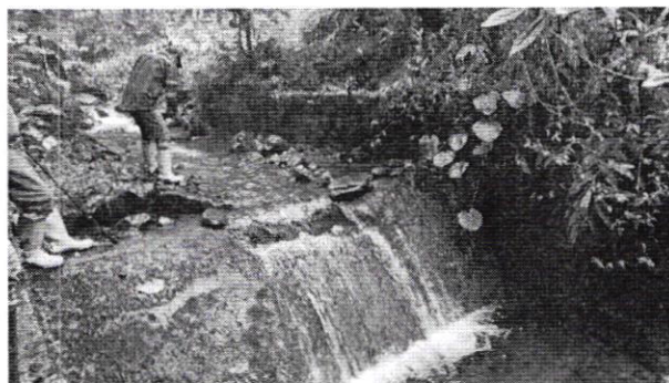
Fotografía 2. Fuente de agua cruda Río Chilicay, Cumandá.
